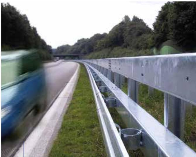
Stahlschutzplanken vom System Super Rail erfüllen die Kriterien für die höchste Aufhaltstufe. Sie wurden mit einem 38 Tonnen schweren Lkw getestet, der in einem Winkel von 20 Grad und mit einer Geschwindigkeit von 65 Stundenkilometern auf die Planke prallt. Bild: Gütegemeinschaft Stahlschutzplanken
